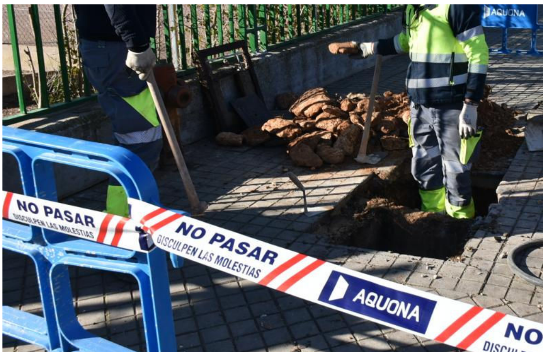
Obras. Imagen de Archivo
