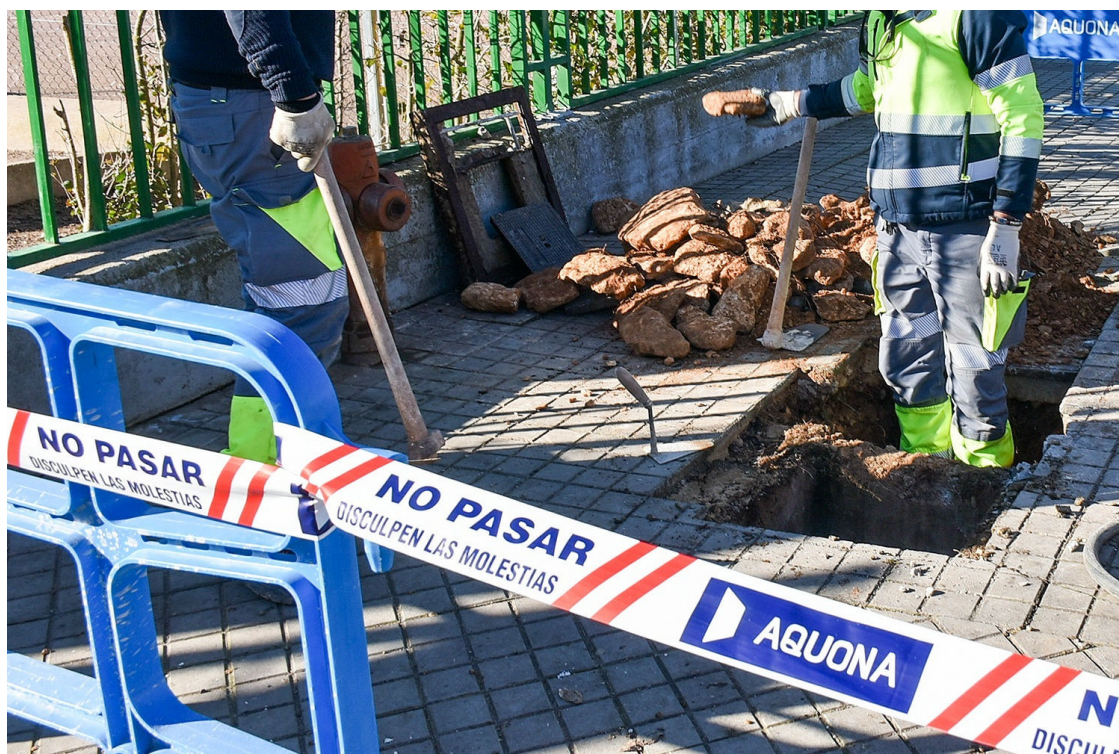
Obras en la red de agua potable de Daimiel / Lanza
